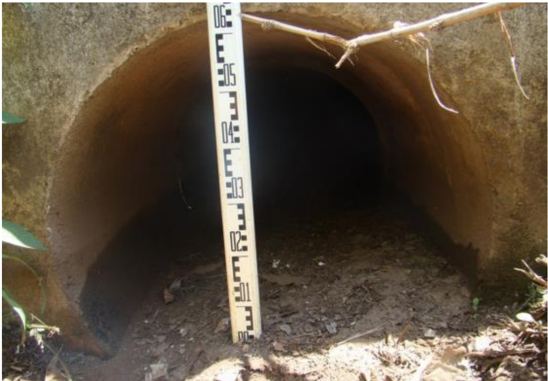
Foto 8. Saída do tubo principal do sistema 2 de drenagem da sub-bacia urbana 1.
