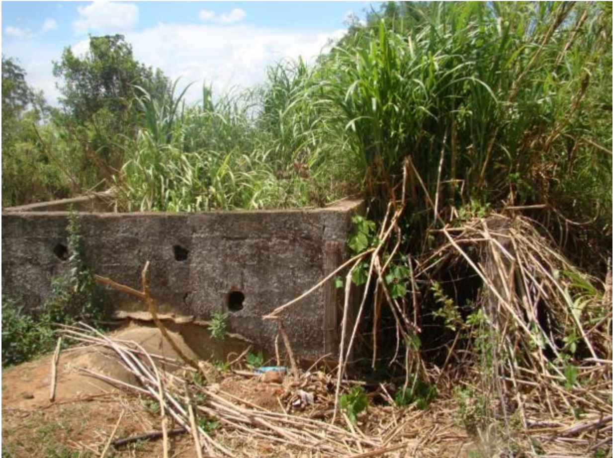
Foto 9. Local do dissipador do tubo principal do sistema 2 de drenagem da sub-bacia 1.
