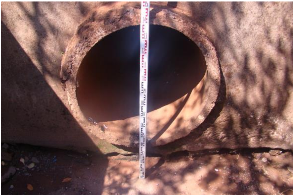
Foto 3: Medição do Tubo Principal do sistema de drenagem da sub-bacia urbana 1.
