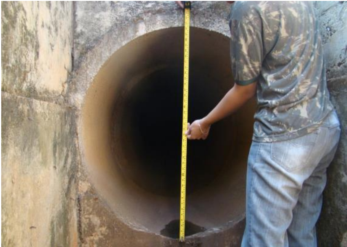
Foto 1: Medição do tubo principal do sistema de drenagem da sub-bacia urbana 2.
