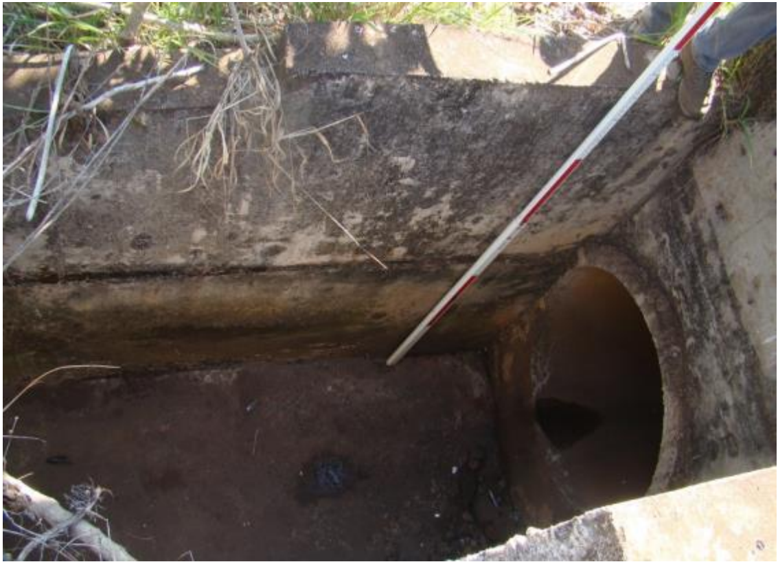
Foto 17. Saída da galeria principal da sub-bacia 2, vista de cima.
