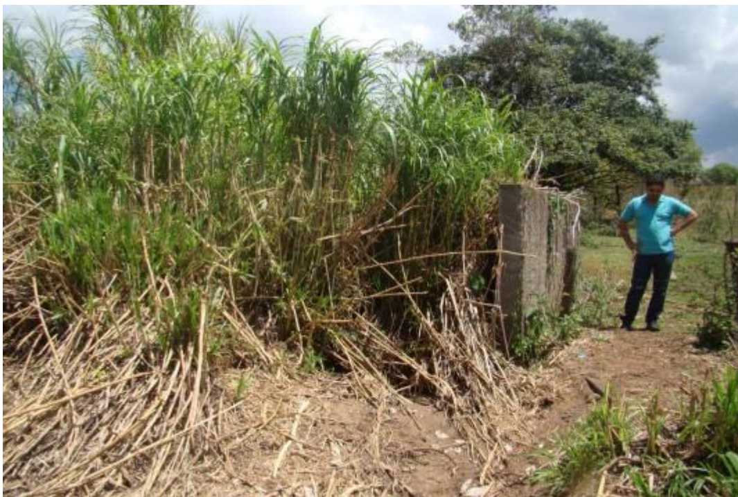
Foto 16. Detalhe da saída frontal do dissipador do sistema 2 da sub-bacia 1.
