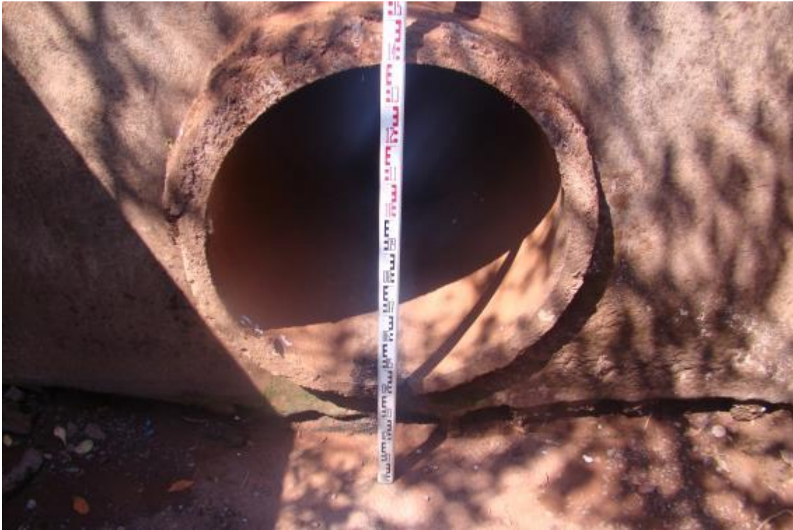
Foto 5. Tubo Principal do sistema 1 de drenagem da sub-bacia 1.
