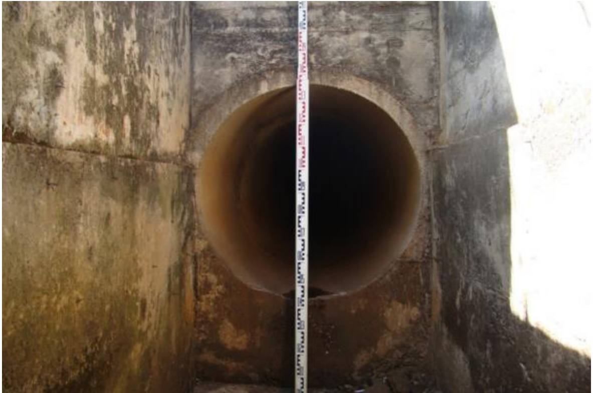
Foto 2: Medição do Tubo Principal do sistema de drenagem da sub-bacia urbana 2.
