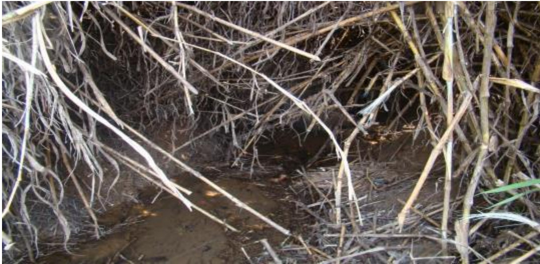
Foto 23. Passagem da drenagem (Rodovia)
