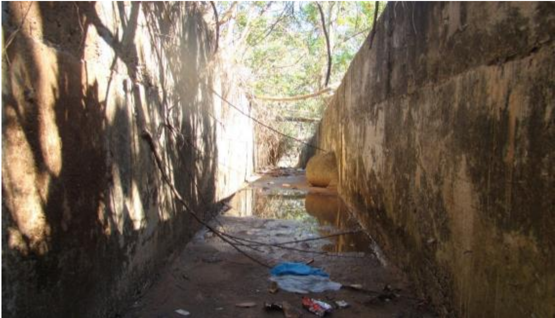
Foto 19. Detalhe do sentido de escoamento das saídas das galerias da sub-bacia.
