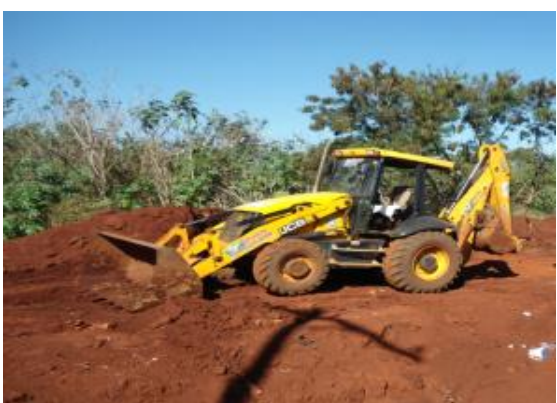
Foto 15: Retroescavadeira usada na manutenção e operacionalização do aterro.
