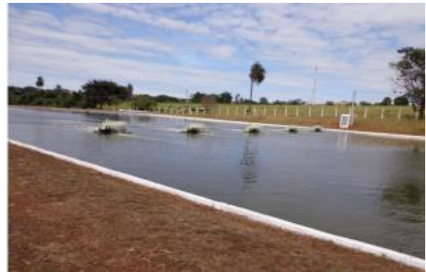
Foto 68: Lagoa de Estabilização (tratamento).
