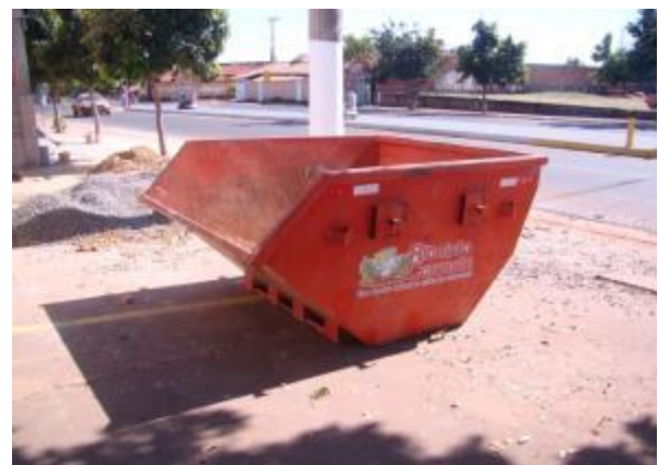
Foto 36: Caçambas contratadas pelos moradores, para armazenar os resíduos inertes.
