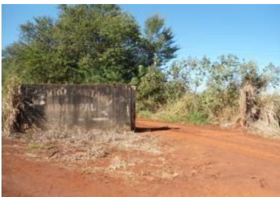
Foto 13: Entrada do aterro sanitário.
